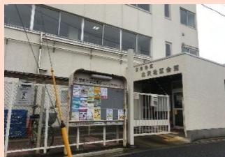
北沢地区会館（外観）
